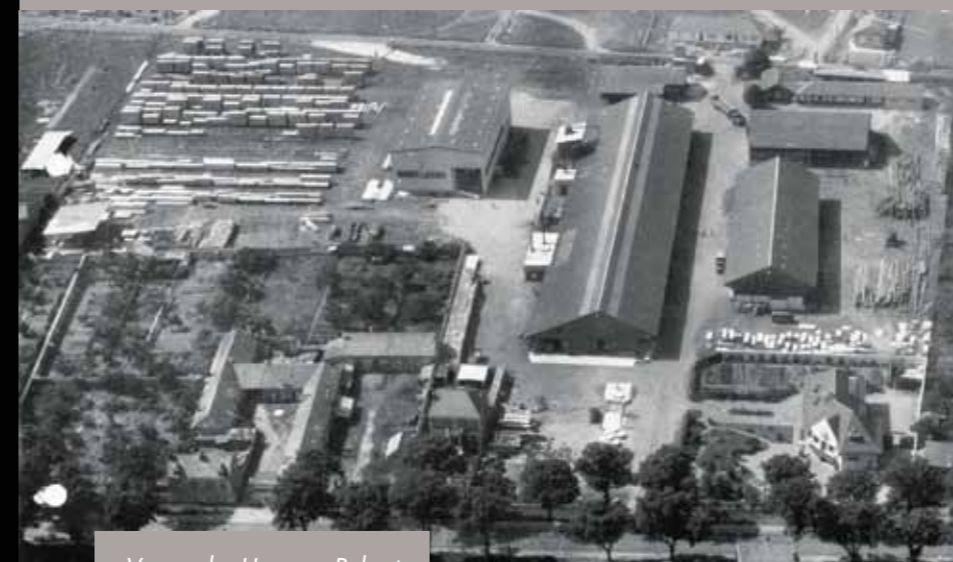
Vue sur les Hangars Robert
